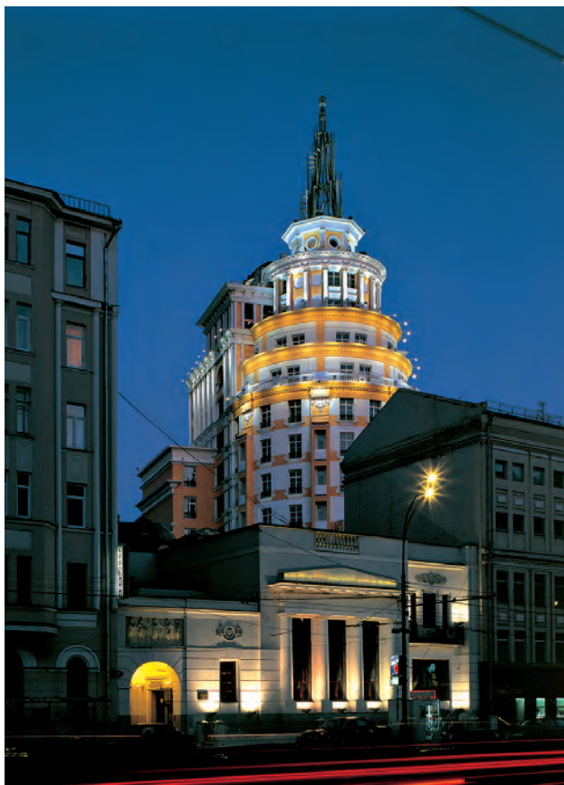
Ил. 18. Капиталистический реализм: через десять лет после распада СССР русская архитектура достигла пика экстравагантных замыслов. Жилой дом на Малой Бронной улице был построен Сергеем Ткаченко в 2002 г. Фото: Александр Русов
