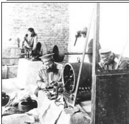
Первая Памирская ГЭС. Здание станции; монтаж динамо-машины Фото из семейного архива Шпилько
