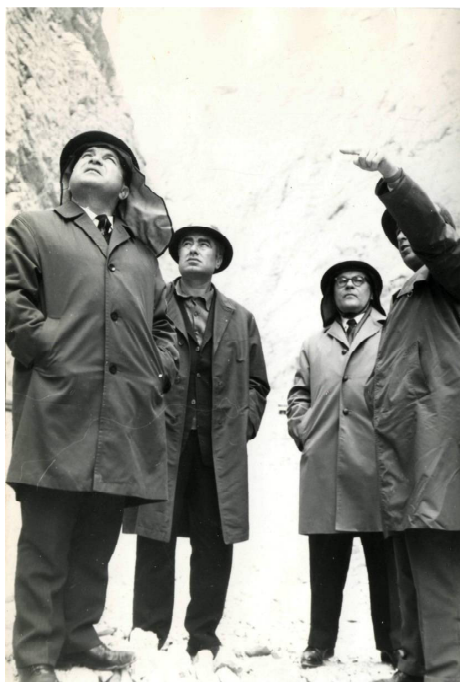
На строительстве Чиркейской ГЭС Л. П. Зеленин (второй справа) с болгарским коллегой Христо Поляновым и специалистами (1970)
