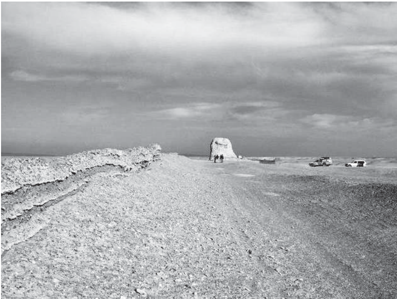
Ханьская Стена в Цзюйяне и сигнальная вышка ханьской эпохи
