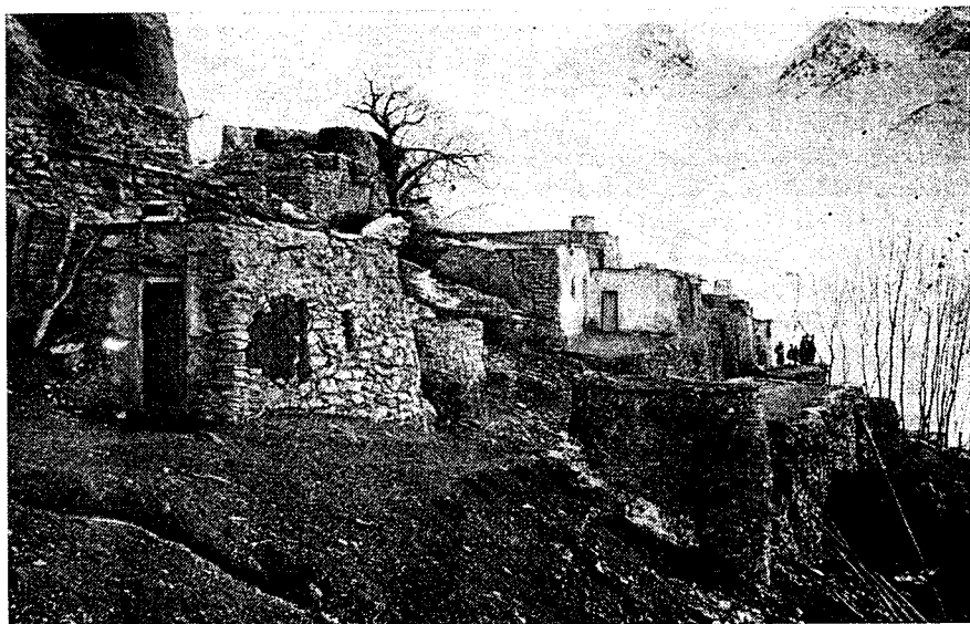
Рис. 6. Жилые и хозяйственные постройки, сооруженные из сланцевого камня в кишлаке Кули-Дахана. Ягноб, 1966 г.
