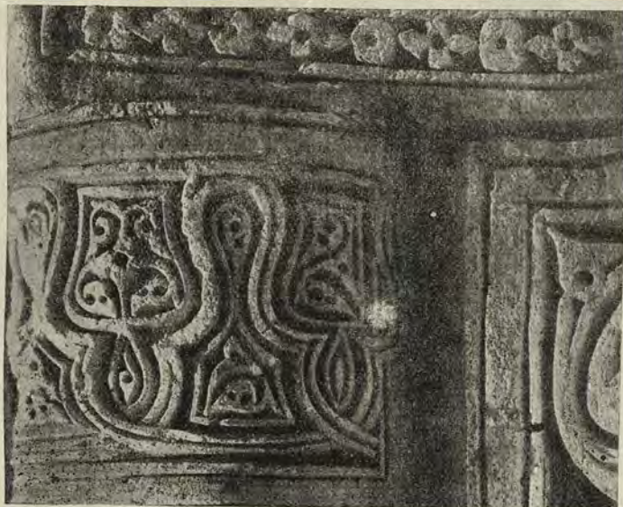
46. Термез. Дворец термезских правителей. Северо-западный угол восточного пилона. Деталь колонны
