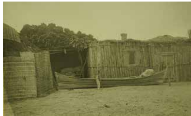
Рис. 13. Каркасные дома из камыша, обмазанного глиной. Каракалпакская АССР, Муйнакский район. 1946. Фото Т.А. Жданко. НА ИЭА РАН
