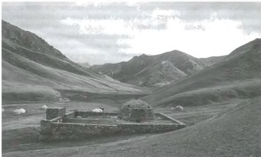
▼ Рисунок 10.1. «Таш-Рабат», простой, но прочный караван-сарай эпохи Караханидов, расположенный высоко в горах на пути из Кыргызстана в Синьцзян
