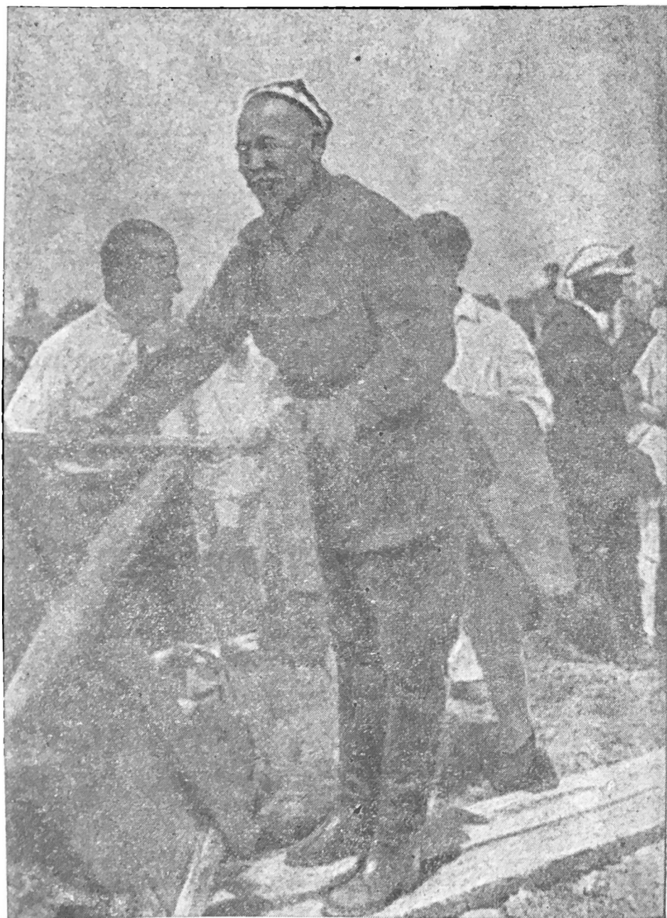
Юлдаш Ахунбаев на строительстве текстильного комбината.
