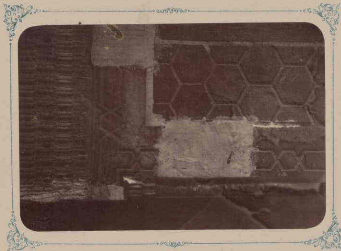
ЧАСТЬ ЦОКУЛЯ ВНУТРИ МАВЗОЛЕЯ.
