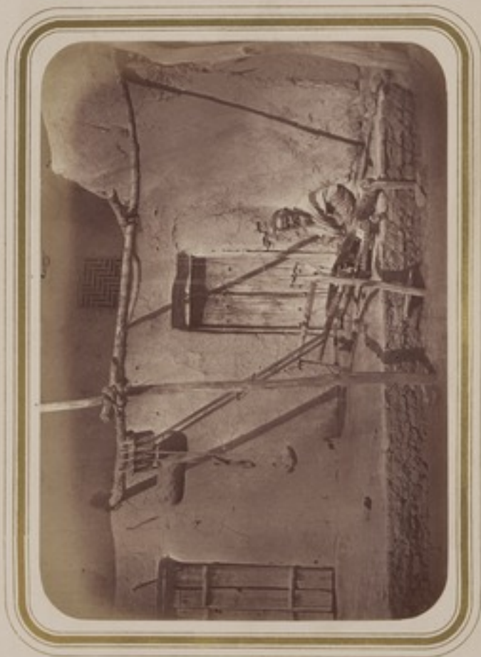
ТКАЦКІЙ СТАНОКЪ ДЛЯ МАТЪ | ДУКАНИ ХАРБАЗЪ |
