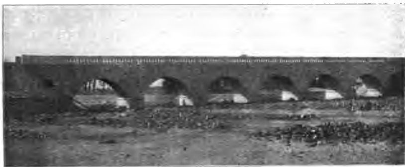
Каменный мостъ черезъ рѣку Лунхэ.
