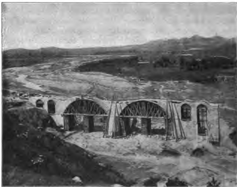
Постройка желѣзнодорожнаго моста на нашей дорогѣ въ Южной Маньчжуріи.
