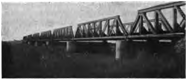
Жельзнодорожный мостъ черезъ Пѣйхо у Янцуня.
