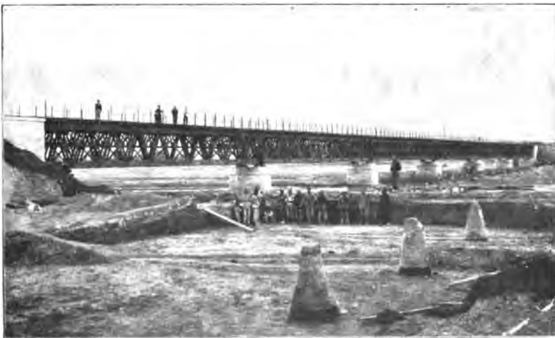
Желѣзныя мосты черезъ рѣку Наньдаэхъ.
