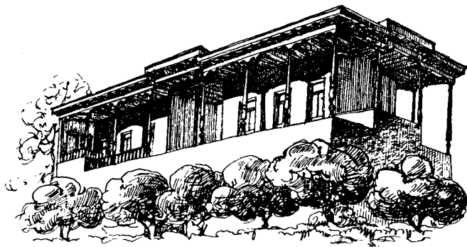
Рис. 17. Дом Турсункулова в колхозе им. Куйбышева, Комсомольского района, Самаркандской области. Трехсторонний айван с акцентами по осям и сквозная лоджия в центральной части здания
