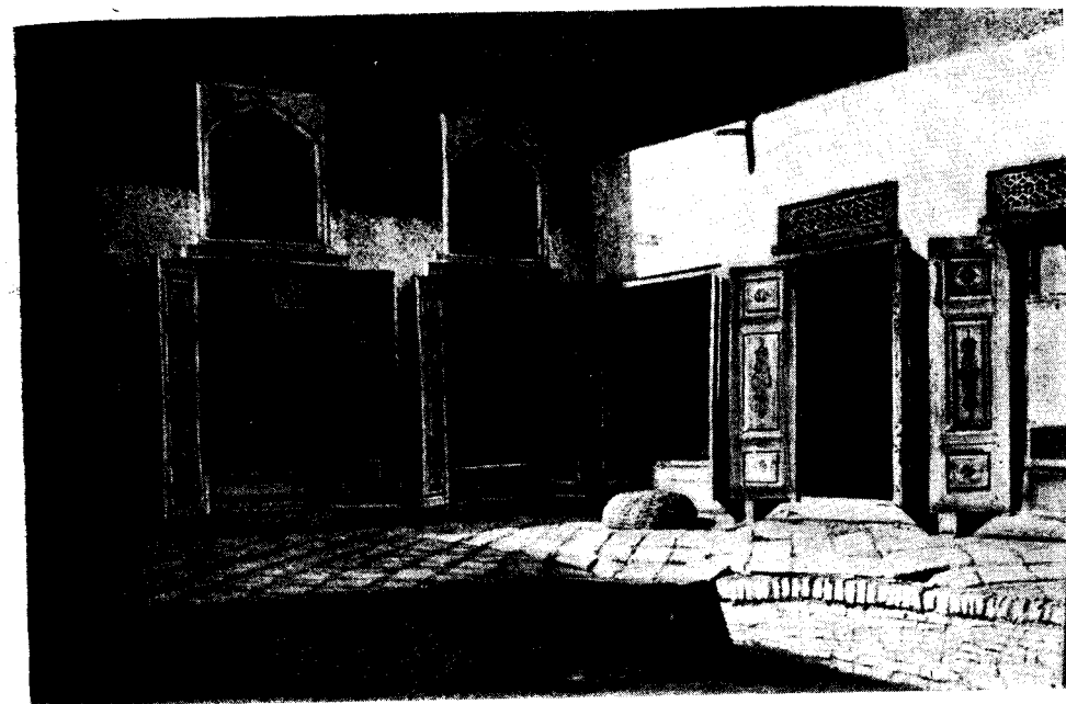
Рис. 8. Бухарский дом с открытыми террасами
