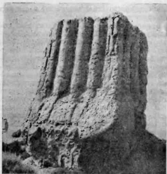
Рис. 201. Угловая башня жилой усадьбы Наиб-кала (древний Хорезм)
