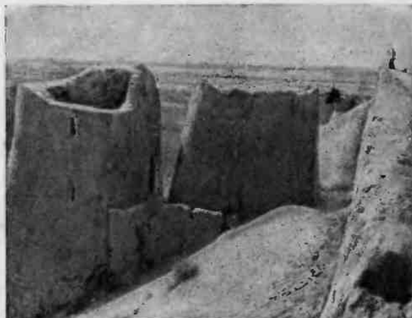
Рис. 170. Часть крепостной стены Гульдурсуна
