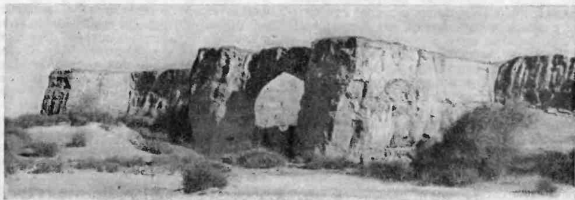
Рис. 184. Общий вид жилого дома усадьбы № IV в районе Кават-кала
